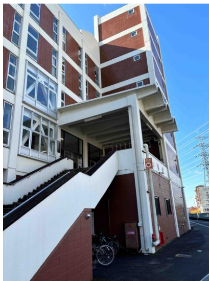
写真② (4号館入口)
