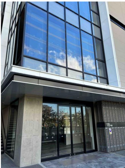
写真① (18号館入口)
